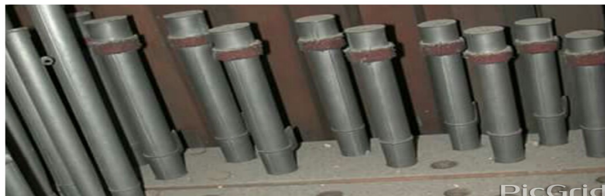
znečistený a poškodený píšťalový fond a vzdušnice
