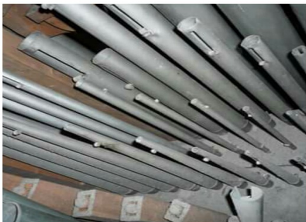
poškodené ladičky, píšťaly po oprave a čistení
