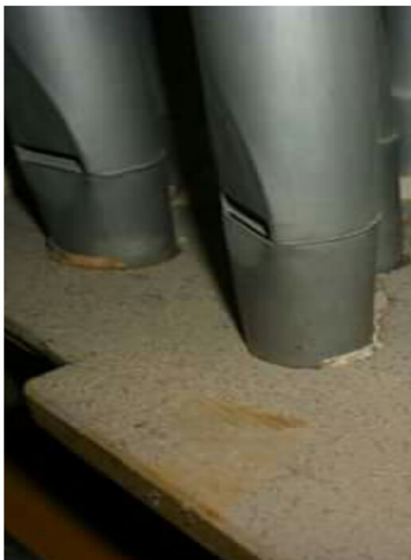
znečistený a poškodený pískalový fond
